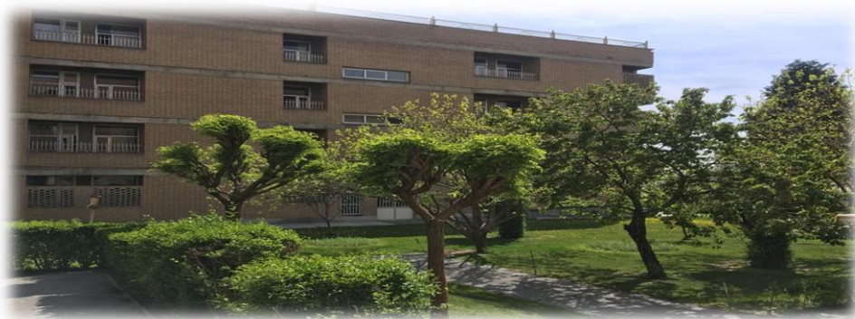
تخلیه کامل خوابگاه ۶ اسنفد ۹۸
